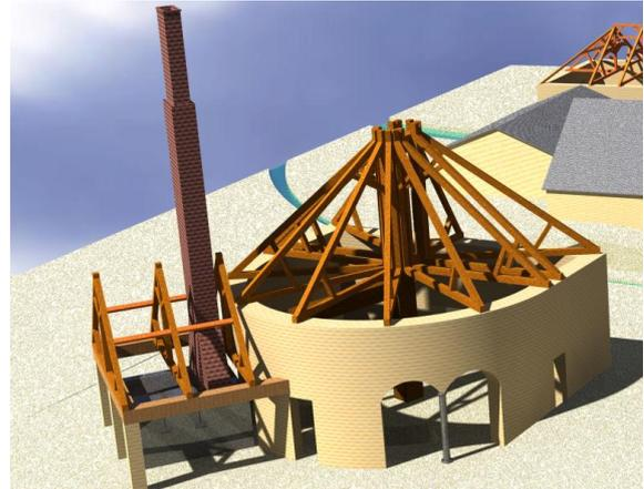
La Fonderie sert à refondre la fonte issue des Hauts-Fourneaux dans des fours à réverbère afin d’obtenir de la fonte plus homogène. Celle-ci est ensuite moulée.
